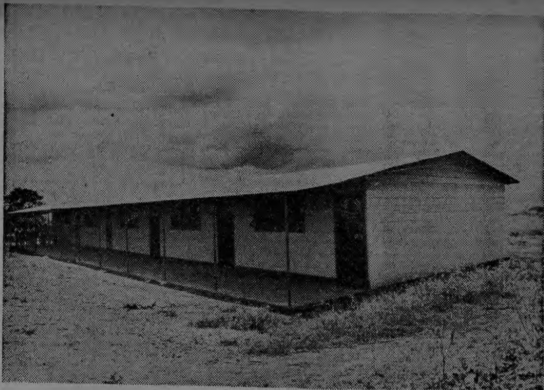
NUEVO PABELLON con cinco aulas para la Escuela de la Finca La Argentina ha sido recientemente construido, en demanda de la población estudiantil. El costo de la obra es de diez millones de colones cada aula.
